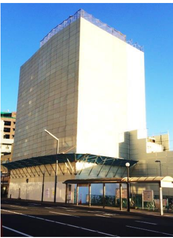
解体工事の飛散防止壁が 組まれたたかみビル
