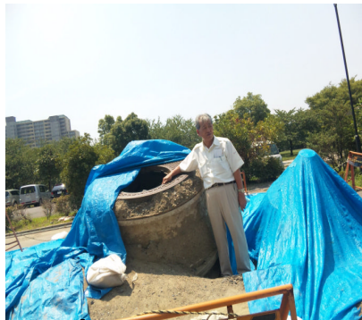
高洲中央公園内 耐震性貯水槽
