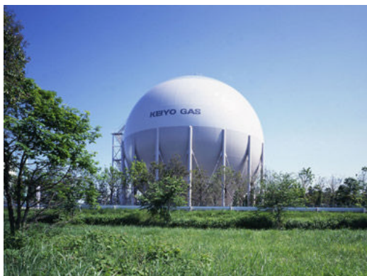
写真は白井市供給所ガスホルダー
